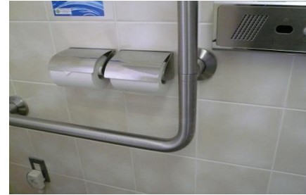
手すり (トイレや廊下)
