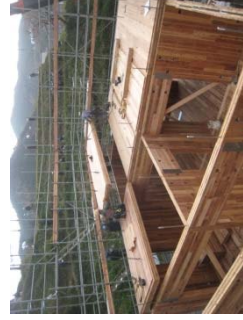
CLTを用いた施工例
