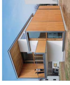
CLT(直交集成板)パネル CLT工法による実験棟
