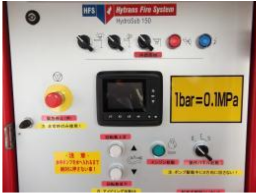
中央のディスプレイでエンジン回転を制御し、送水を開始する
