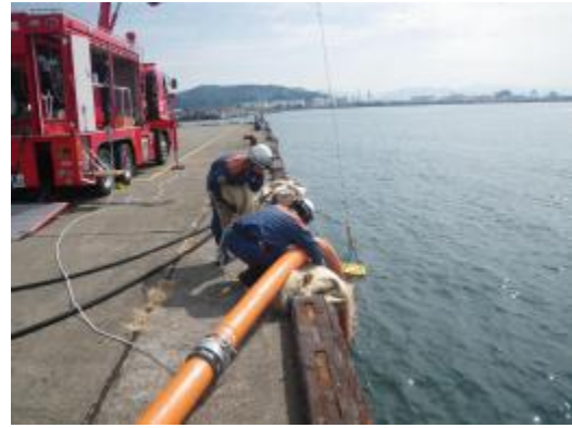
水中ポンプから150mmホースに送水される
