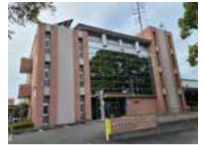
⑧ 東温市消防本部・東温市消防署
