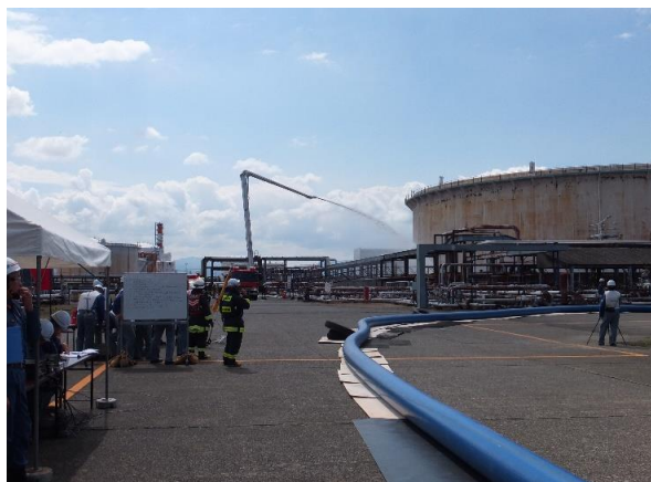
19 一斉放水状況
