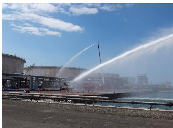
18 一斉放水状況
