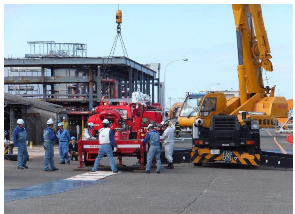
12 大容量泡放射システム設置状況①
