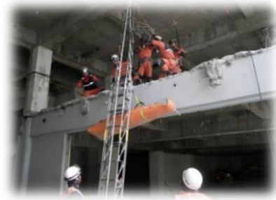
三連梯子を設定し、 進入・救出導線の確保
