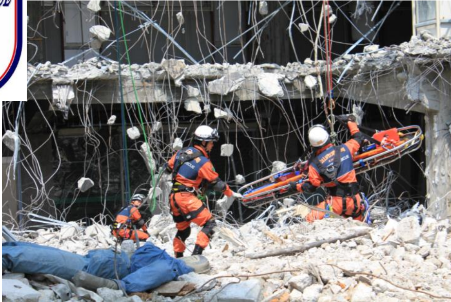
解体建物内での救助訓練風景
