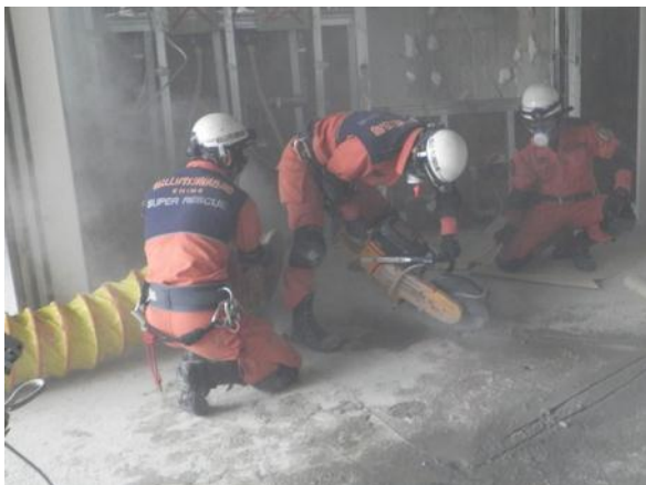
鉄筋コンクリート突破訓練風景
