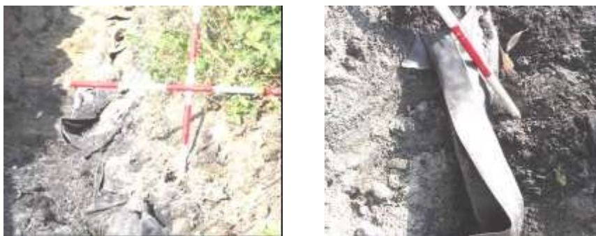
図Ⅱ-18 遮水シートの状況
