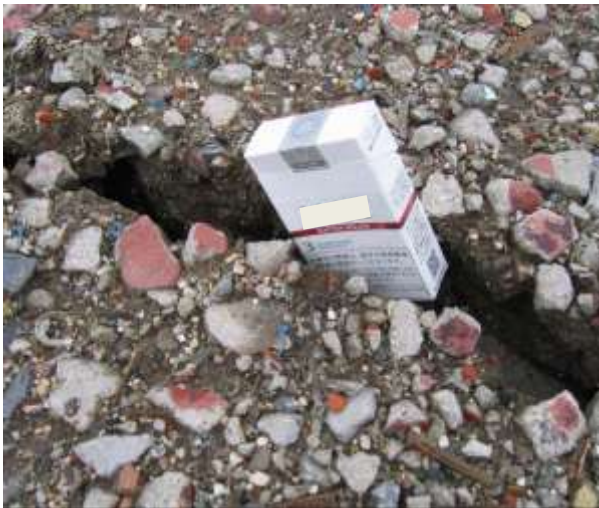
図 I - 7 埋立地内亀裂発生状況 (右 : H23. 6. 15、左 : H23. 9. 4)
