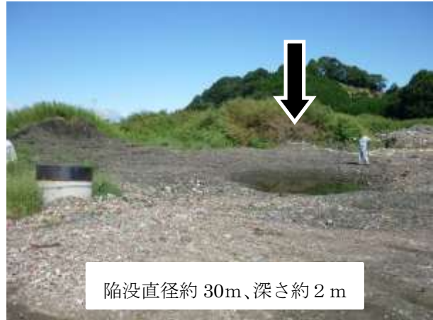
図 I - 6 地下水路出口からの灰濁水 (H23. 9. 3) 及び埋立地内陥没状況 (H23. 9. 5)
