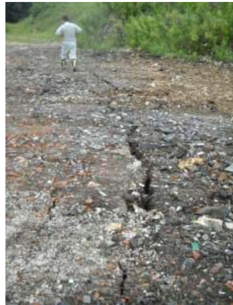
図 I - 7 埋立地内亀裂発生状況 (右 : H23. 6. 15、左 : H23. 9. 4)
