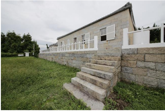
附 北方石垣（北西から）
