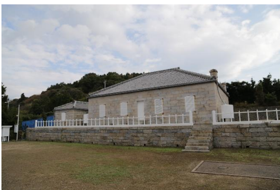
旧官舎及び倉庫外観（北西から）
