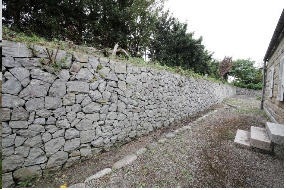
附 南方石垣（北東から）
