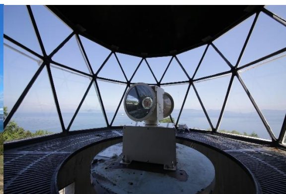
釣島灯台 灯籠内部（南から）
