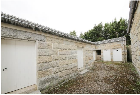
旧倉庫外観（南西から）
