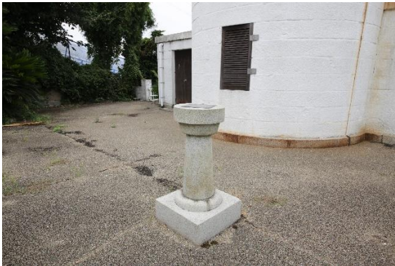
附 旧日時計（南東から）
