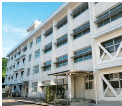
耐震化された校舎
