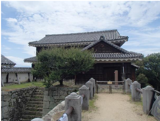
図 6-28 建造物に隣接する植栽木
