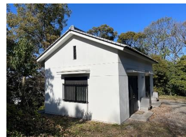
電気設備（電気室）
