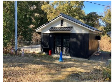
消火設備（ポンプ室・水槽）
