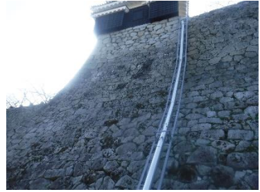
排水設備（排水管）
