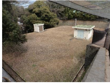
水道設備（東雲配水池）
