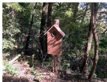
電気設備（メーター）
