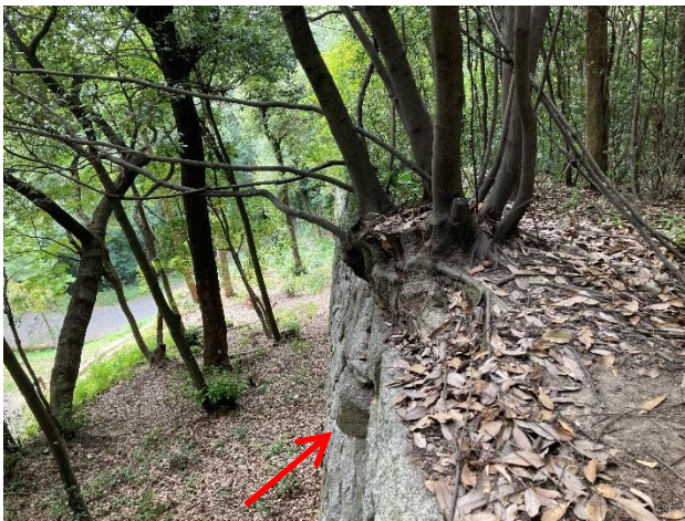
図 3-47 天端石付近に生育する樹木の根系による石垣の孕み
