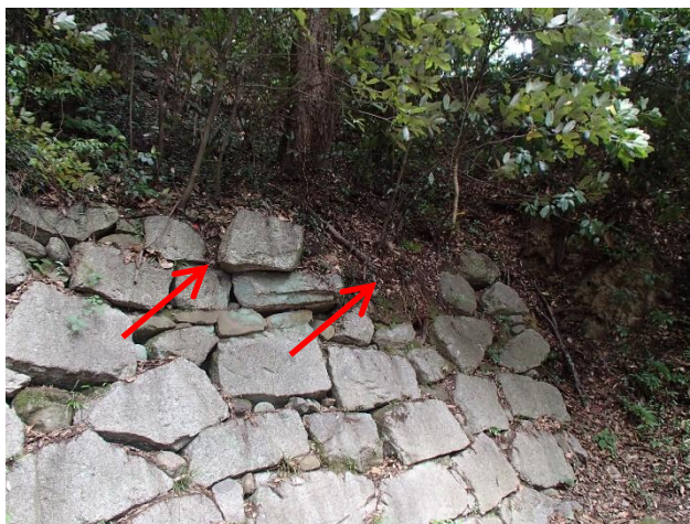
図 3-48 天端石付近に生育する樹木の根系による石垣の孕み、石垣の落下跡
