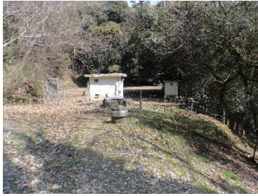
水道設備（城西配水池）
