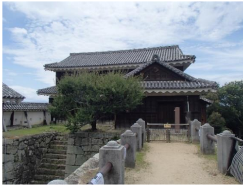
現存建造物と隣接する植栽木
