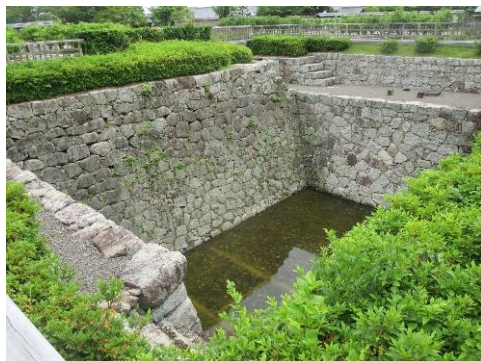
二之丸 大井戸遺構（池）
