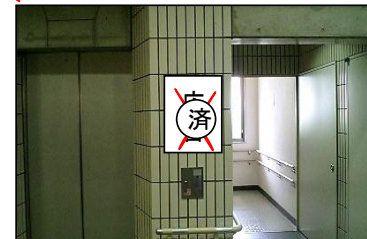
⑥1階エレベーター扉横掲出場所
