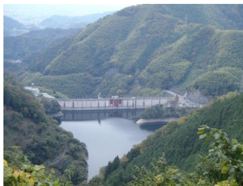
上流から見た石手川ダム
