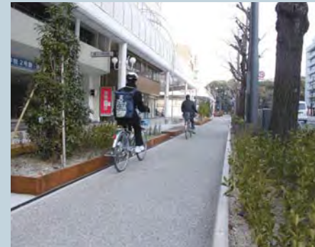
自転車道は洗出しコンクリート
