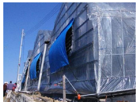
換気扇部分の被覆例
