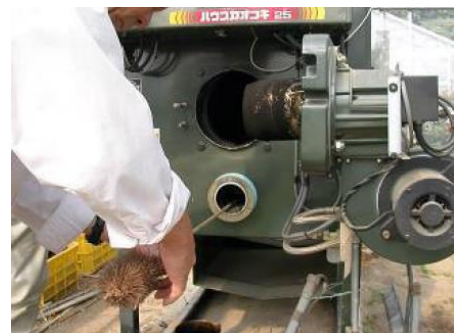
暖房機の清掃・点検
