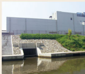
和泉雨水排水ポンプ場
