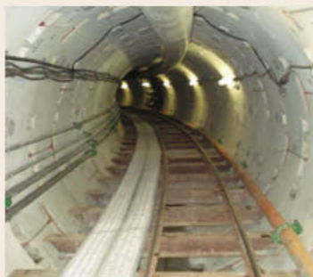
朝生田雨水管(管径2.4m)
